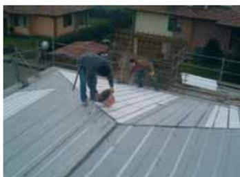
Suivant la structure de la charpente, les panneaux peuvent être installés verticalement ou horizontalement.
